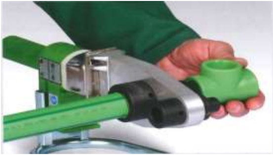
CHAUFFE DES ELEMENTS
